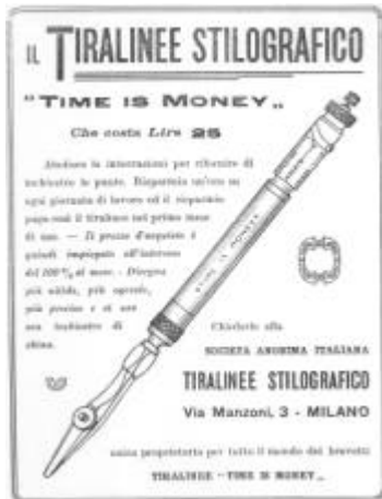
Figura 6: un curioso tiralinee con serbatoio d'inchiostro, precursore delle attuali penne a china (1911)
