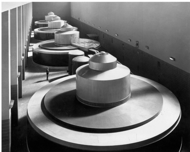
L'impianto idroelettrico della Pickwick Dam (TN), con 4 generatori per 144.000 kW di capacità, in attività dal 1938.
