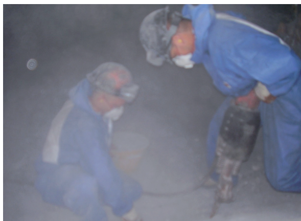
Figura 4 - Demolizione della parete di materiale refrattario di forno fusorio.
