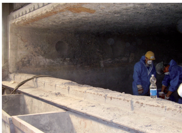
Figura 1 - Rifacimento del materiale refrattario di forno fusorio.
