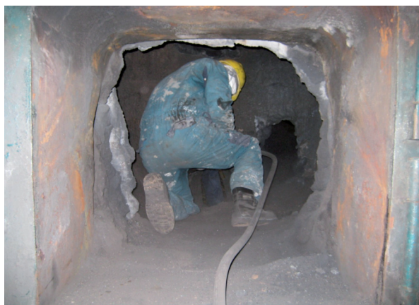
Figura 3 - Demolizione della parete di materiale refrattario di forno fusorio
