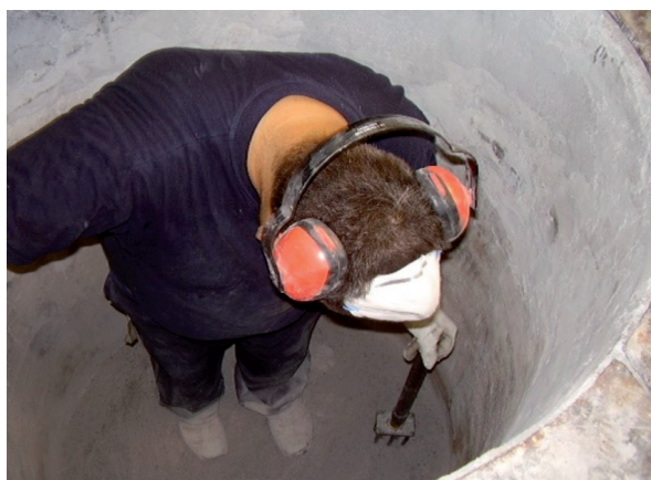
Figura 2 - Manutenzione di materiale refrattario in forno fusorio.
