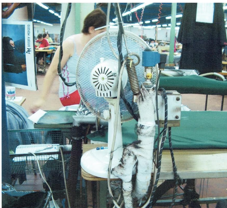
Pietro Gino Barbieri. Coibentazione tubazione di vapore nello stiratoio. Dello (BS), 2006
